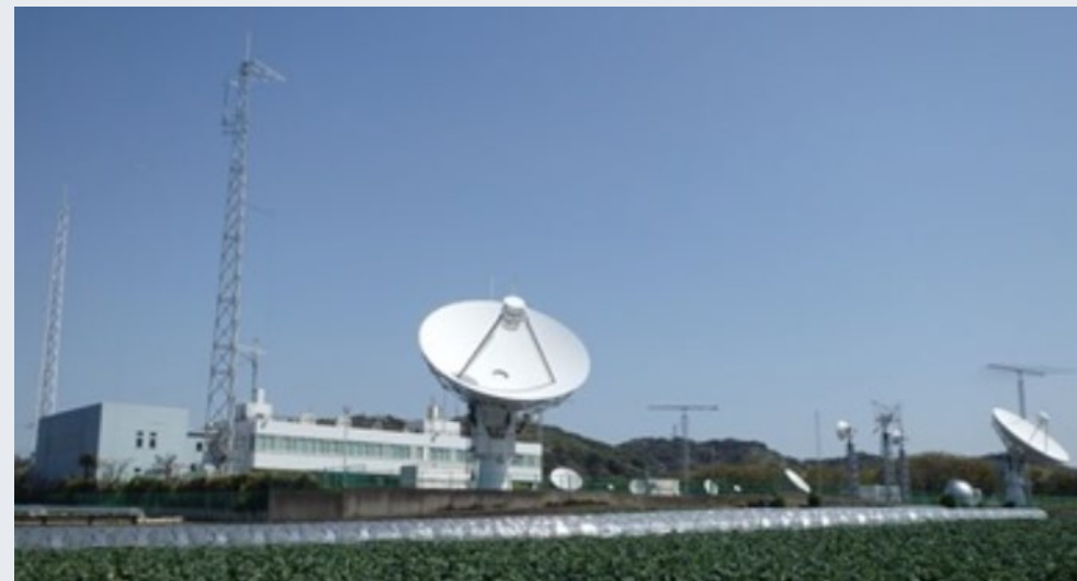
宇宙電波監視を行っている三浦電波監視センター 出典: https://www.soumu.go.jp/soutsu/kanto/re/ucyuu/index.html
